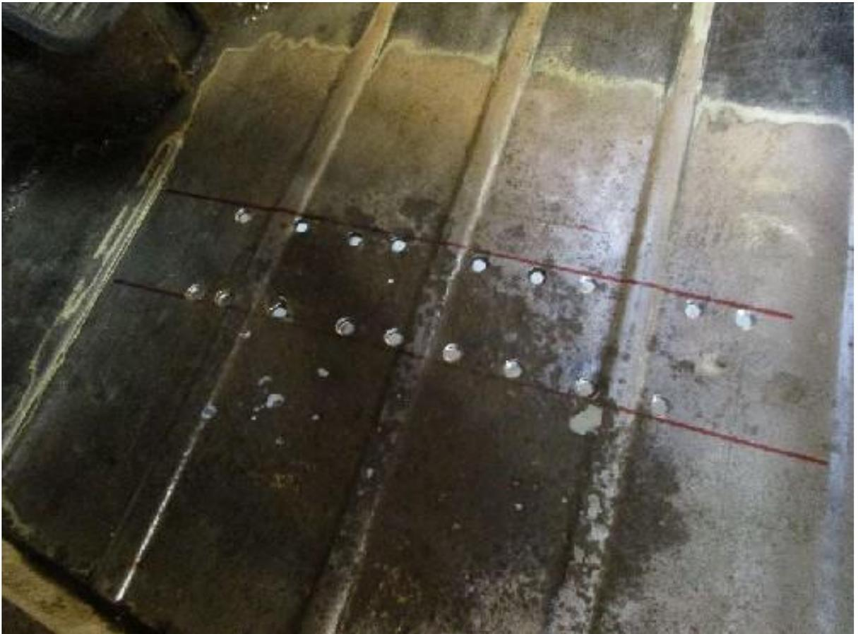
Découpe de la partie corrodée, en préservant le restant du renfort de plancher en V.
